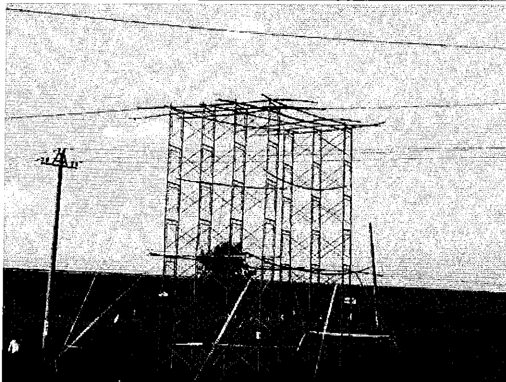
Hình: minh họa dàn giáo vượt đường dây điện lực
